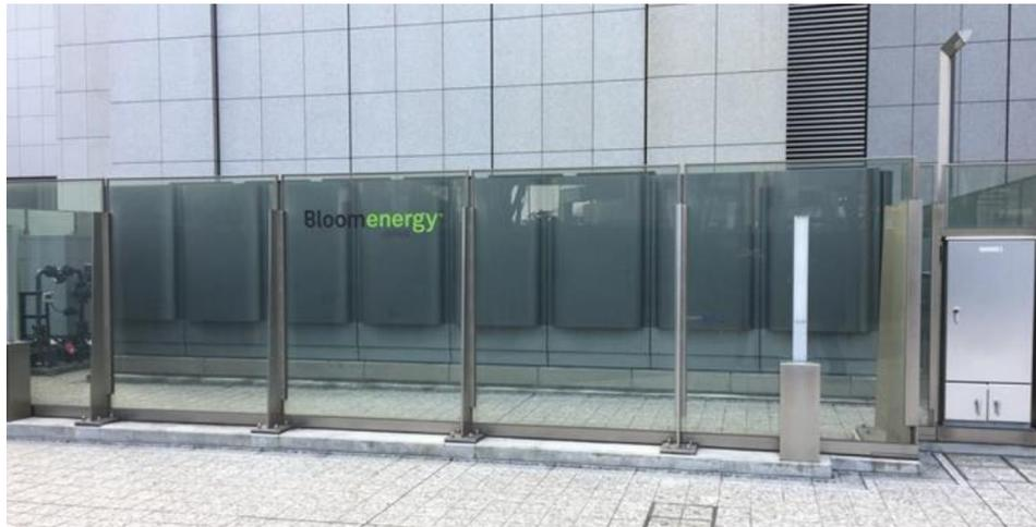
圖 2. 東京汐留大樓一樓室外的 250 kW SOFC 發電系統
