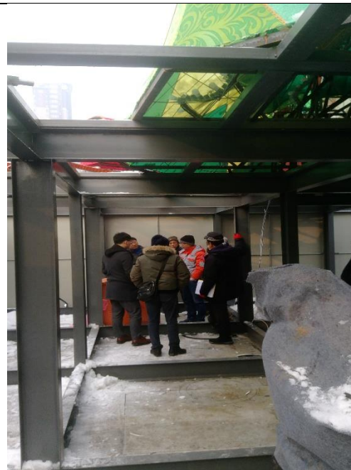
圖四主燈內部結構及配電盤安裝會勘
