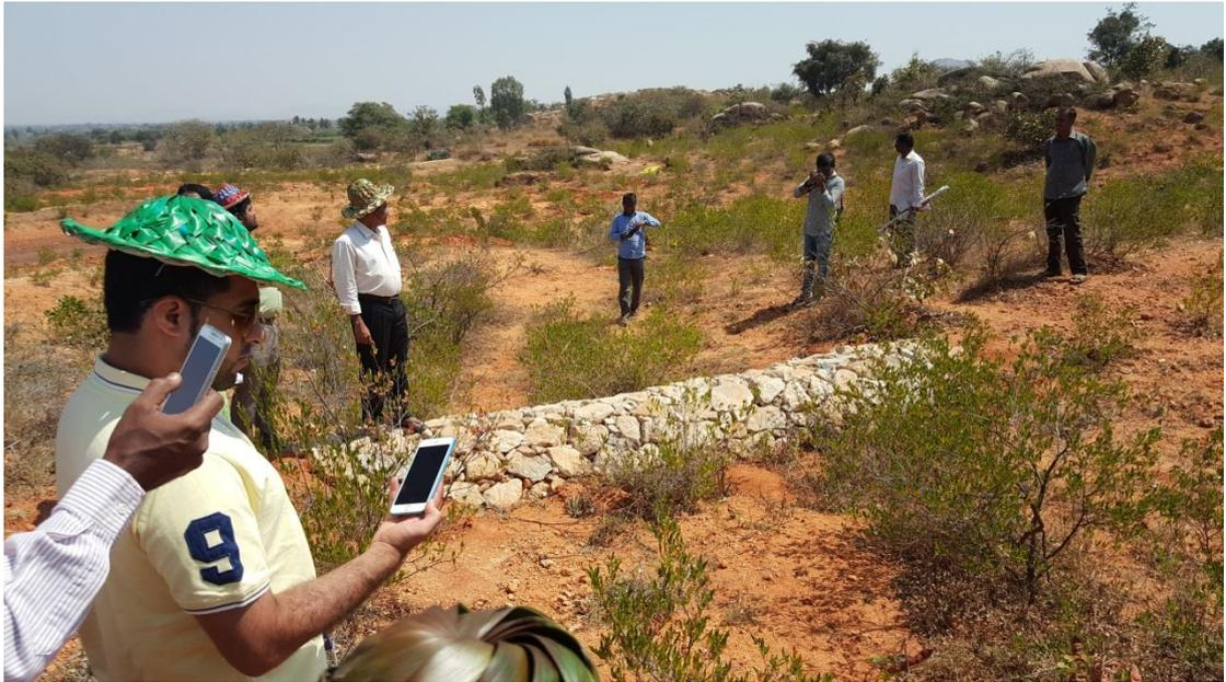
圖 14 現勘照片-現場解說以當地石材減緩表面流速以涵養地下水
