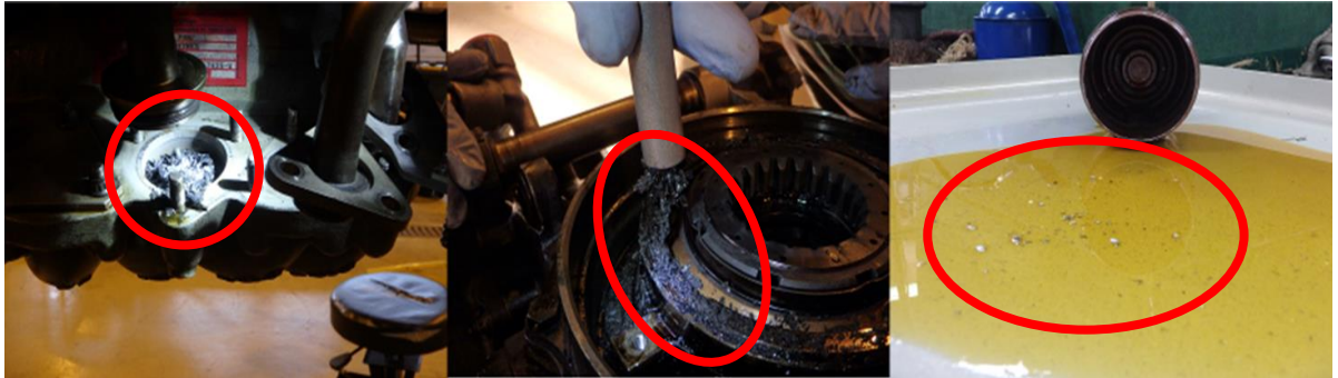
圖三 損壞之齒輪箱軸承
