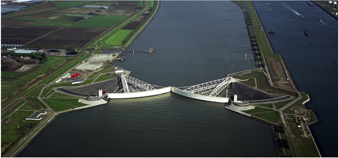
照片 10 Maeslant 防潮水閘關閉情形
