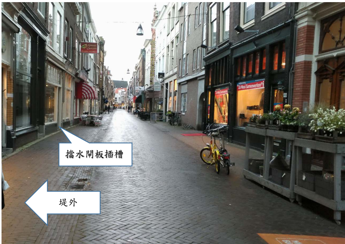
照片 14 在堤防上的建築(一邊堤外，一邊堤內)
