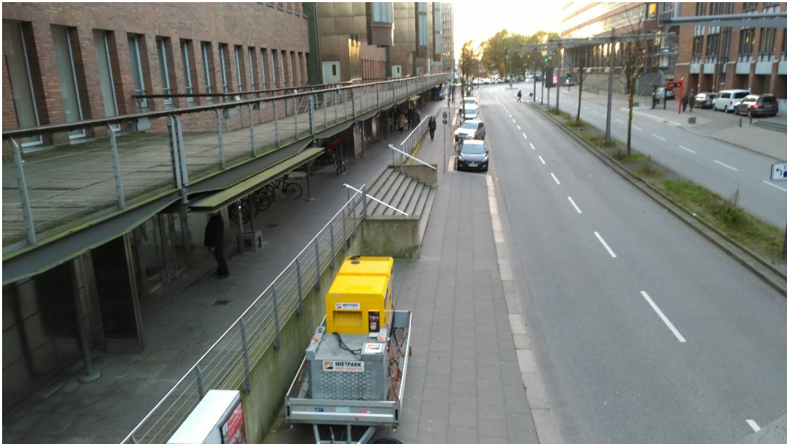
照片 24 設置走道以確保洪災時民眾尚可通行
