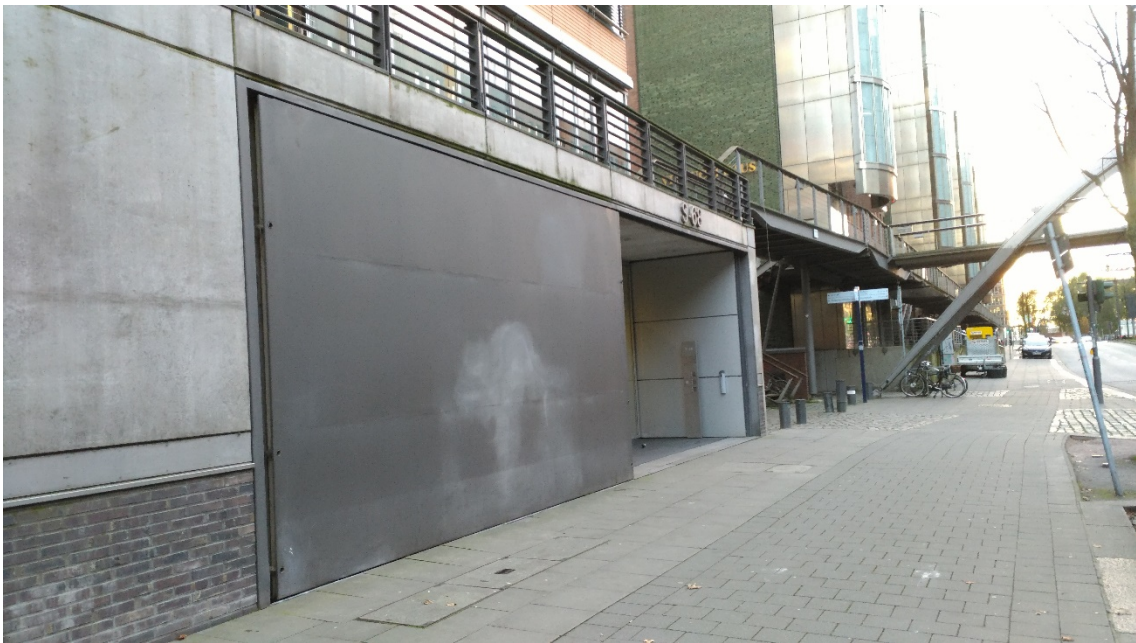
照片 25 一樓設置閘門兼為停車空間
