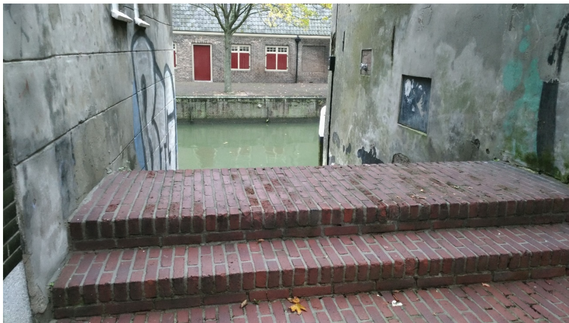
照片 15 建築間空隙透過階梯加高至堤防設計高程
