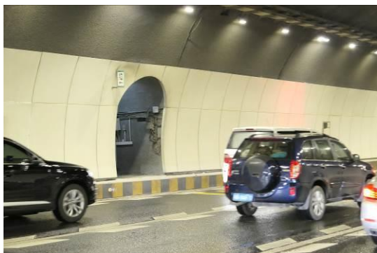
圖 3-3.3 隧道內緊急逃生口
