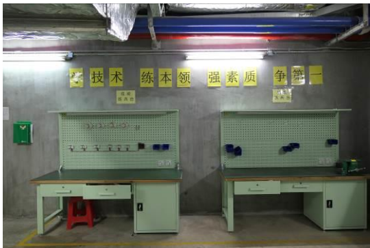
圖 3-2.7 車宮廟站維修作業台
