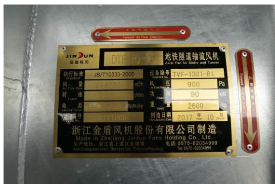
圖 3-4.15 隧道風機銘牌
