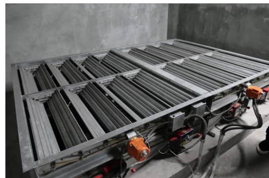
圖 3-5.6 電動多葉風量調整閥
