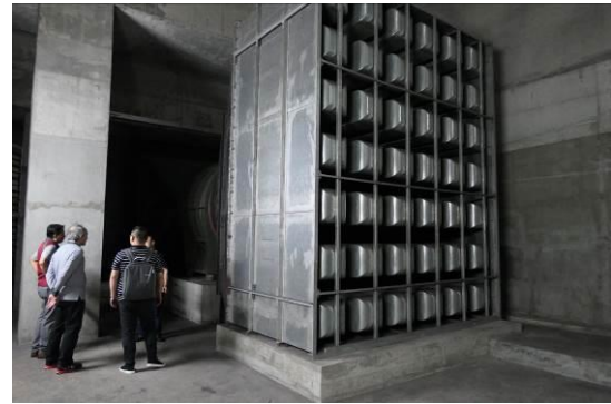
圖 3-2.12 車宮廟站風機與消音器配置
