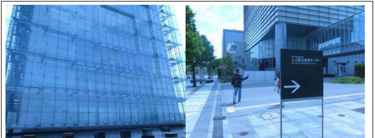
人與未來防災館外觀。建築設計以水泥裸身加上透明玻璃帷幕方式呈現，建築底部與測邊可觀察與耐震相關之鋼結構與隔震制震構造，呼應防震與防災之主題內容。
