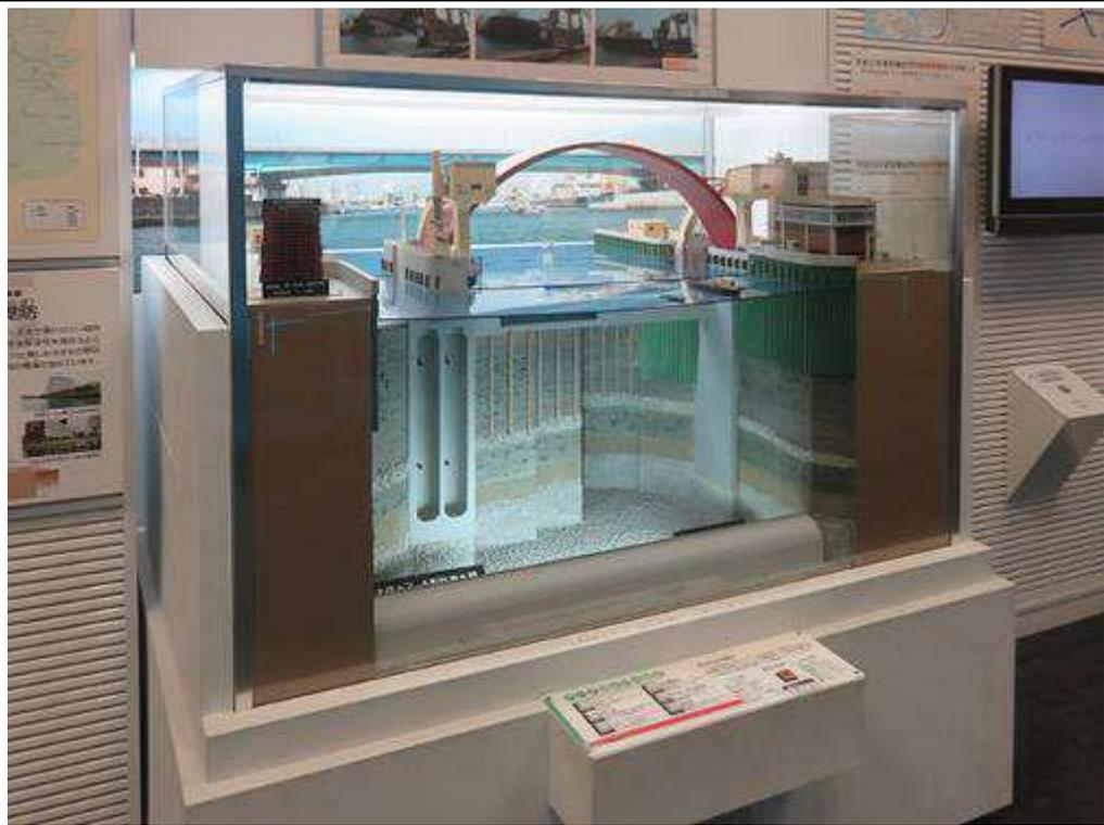
透過剖面模型將大型拱式防波匣門展示呈現，且設計成機構動態顯示，了解水利防災設施之設計原理。
