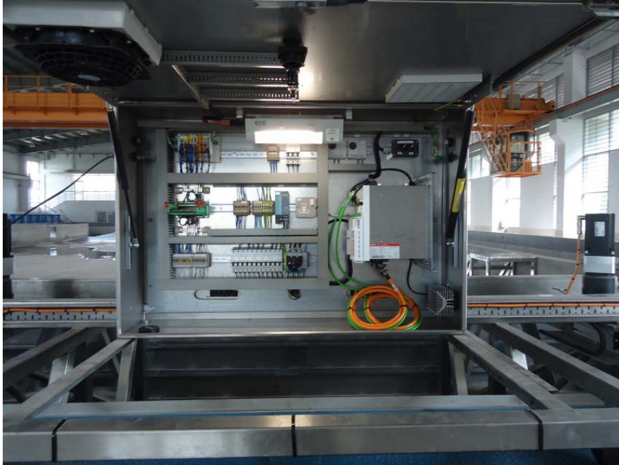
典型馬達驅動控制面板(MDCP)的配置
