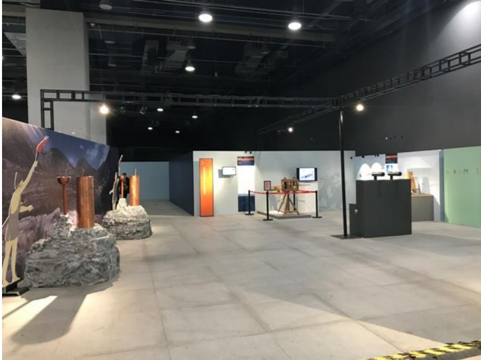
圖十：臨時性燈軌需要和展品背牆結合，轉換場地就需重做，會增加成本。
