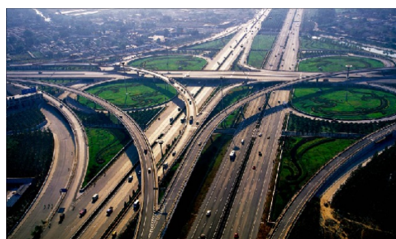
運用大數據技術分析高速公路交通管理情形
