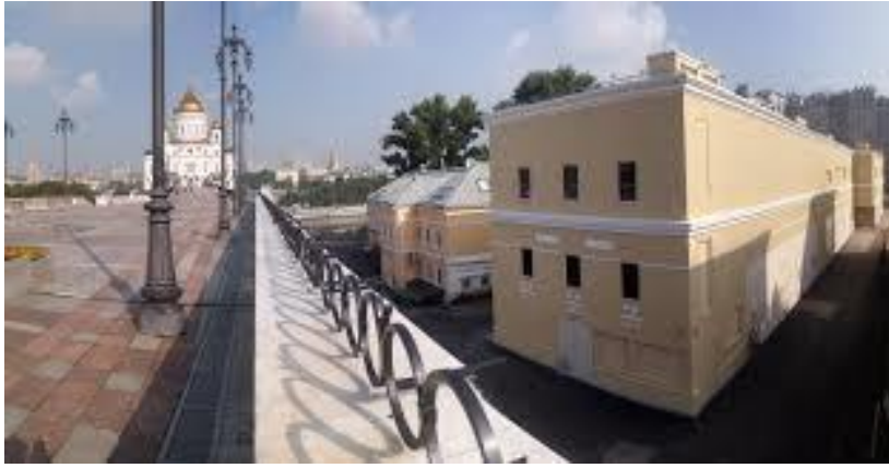
圖 34、莫斯科市中心 Bersenevskaya 變電站
