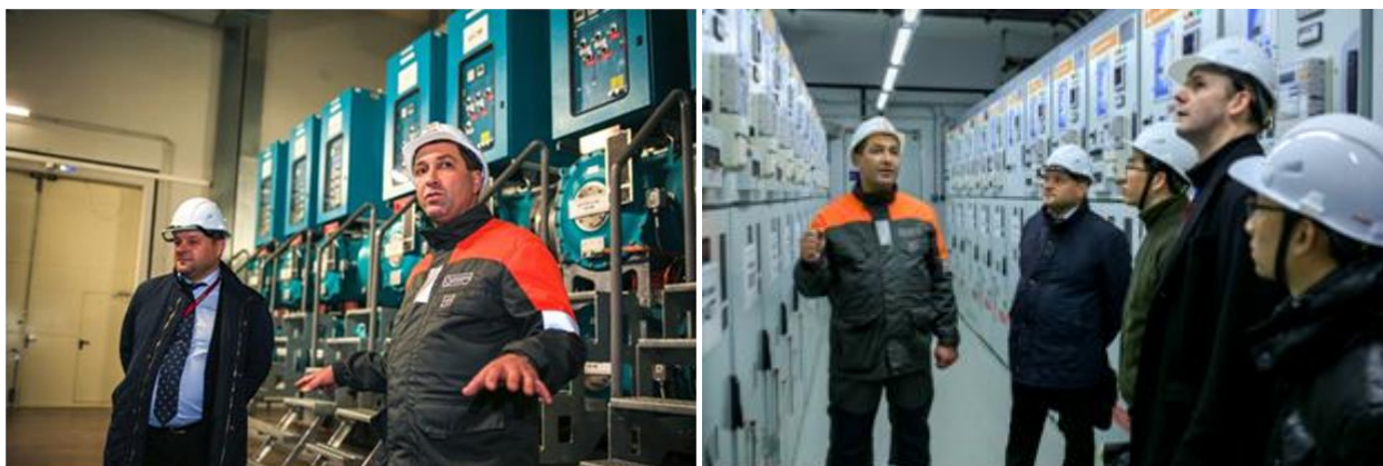
圖 36、變電站內俄羅斯電機工程師講解變壓設備
