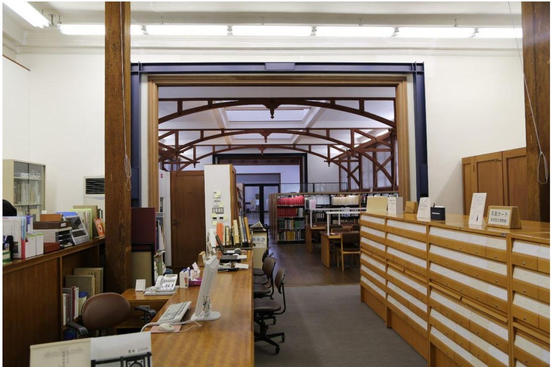
奈良國立博物館附設圖書館結構補強
