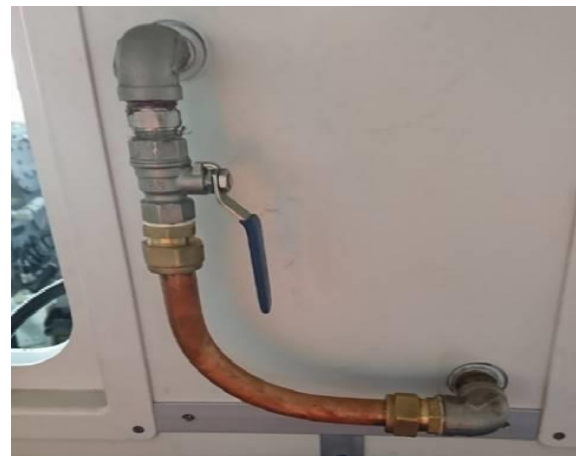
第四批加裝車長閥至空調機下方
