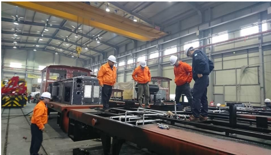
圖2.3.28 空氣配管現場教學
