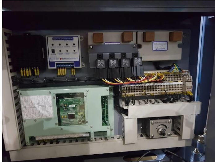
圖2.3.27 兩刷控制器及引擎超速檢測器
