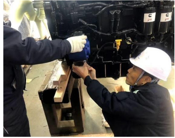
主風泵 PTO 現場組立
