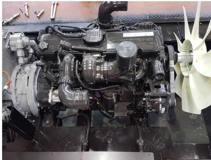
圖2.3.82 引擎動力套件安裝-2
