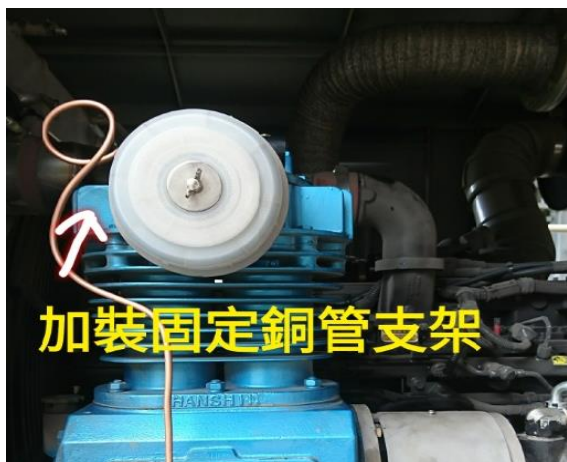
因主風泵銅管加裝固定支架
