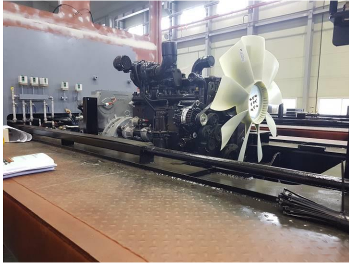
圖2.3.81 引擎動力套件安裝-1
