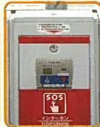
（ホーム柵部） (Platform gates)
