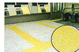
視覚障害者誘導用ブロック
