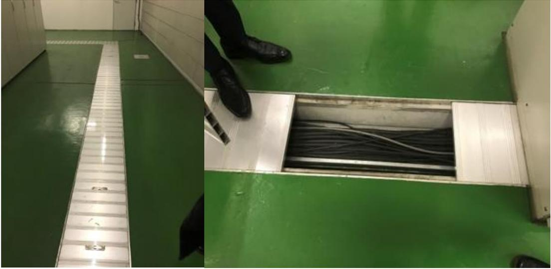
圖 3.3.24 筑波快鐵機電房採用地板線槽，施工細緻平穩
