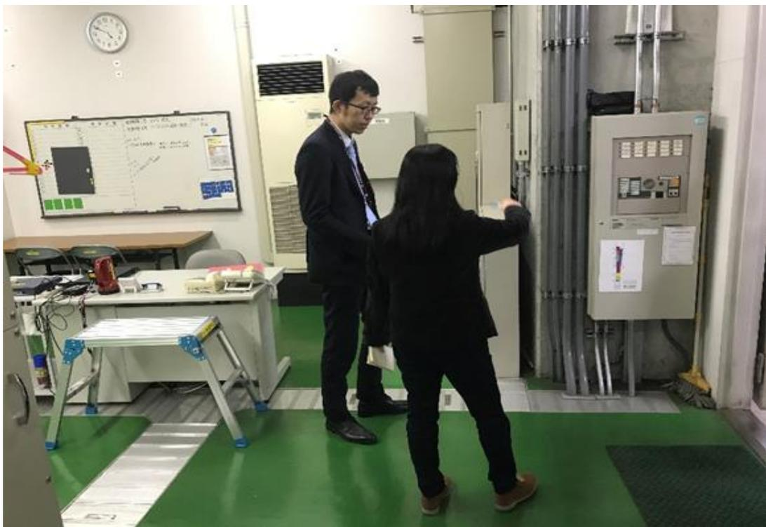
圖 3.3.29 筑波快鐵秋葉原站，在重要電力機房區自設火警警報系統，然後再移報至全車站的火警系統內，電力機房內亦有人員駐點
