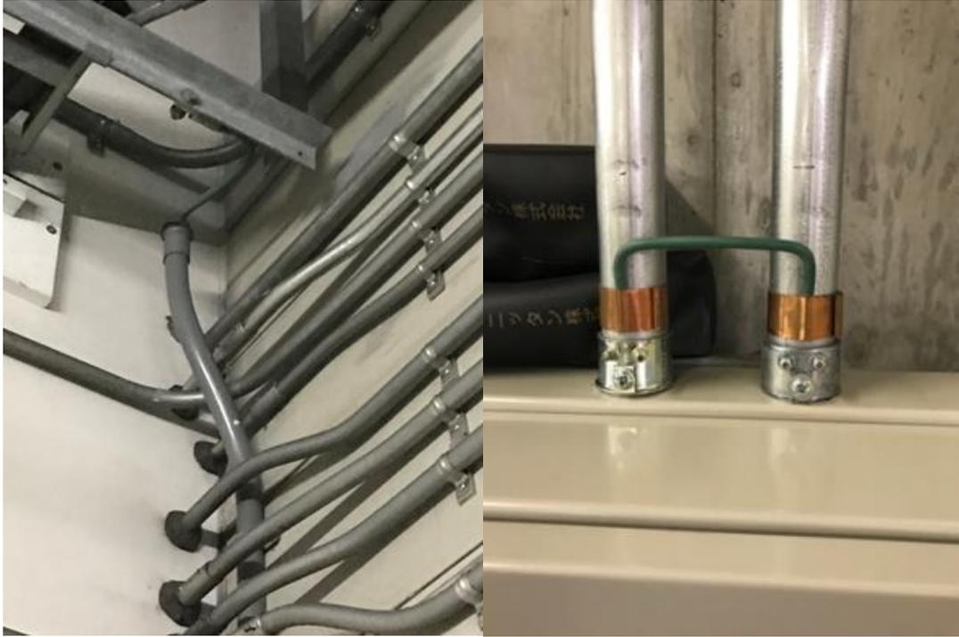
圖 3.3.28 筑波快鐵機房管路施工防火填塞品質良好及管線之接地確實施工
