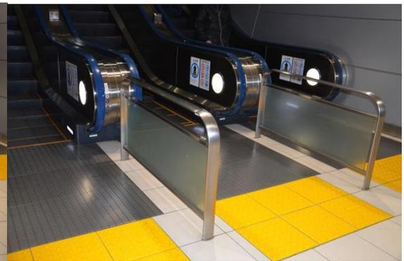
圖 3.3.13 電扶梯區隔板採圓弧設計，避免撞傷
