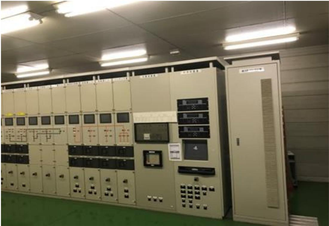
圖 3.3.25 筑波快鐵因採地板線槽，盤體上方就無相關配線，因此在盤體上方設有防水接水盤
