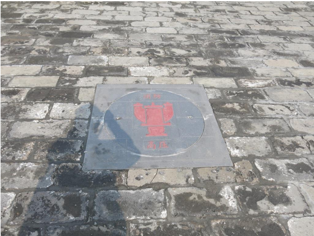
圖 12：北京故宮博物院院區之消防水道、電線電路在古蹟磚石路上地下化。
