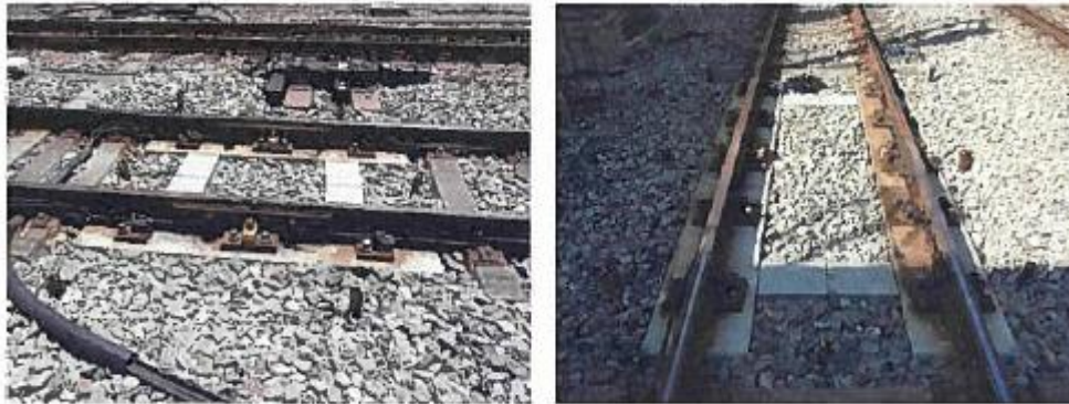
敷設事例（普通絶縁継目 左写真：3締結 右写真：5締結）
