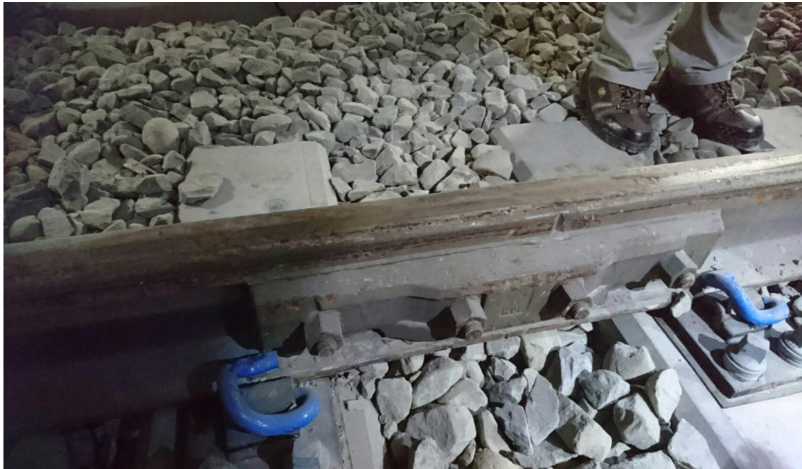
圖 62 改良型斜接夾膠絕緣接頭照片(2)
