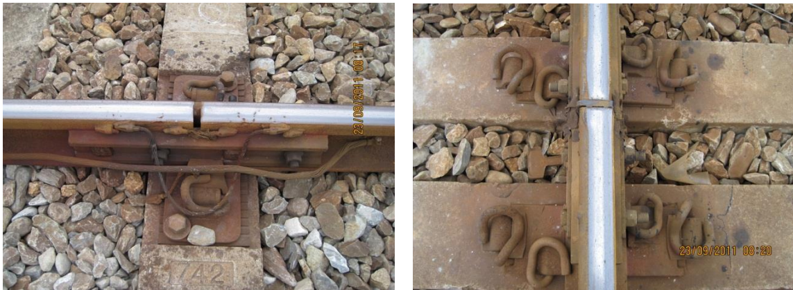
圖 58 臺鐵局接頭均採用端部垂直接合
