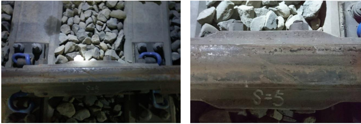
圖 61 改良型斜接夾膠絕緣接頭照片(1)
