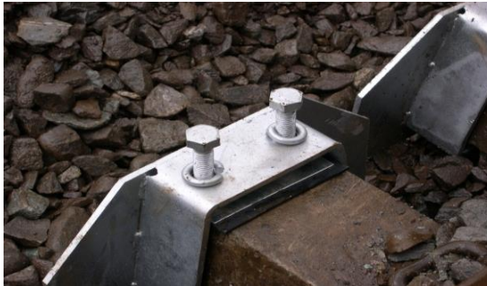
圖 71 臺鐵局挫屈防止鈹安裝
