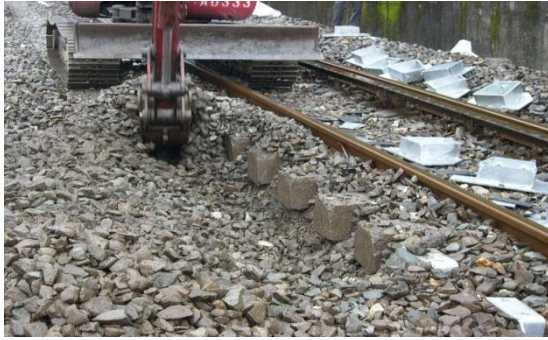
圖 70 臺鐵局挫屈防止鈹施工
