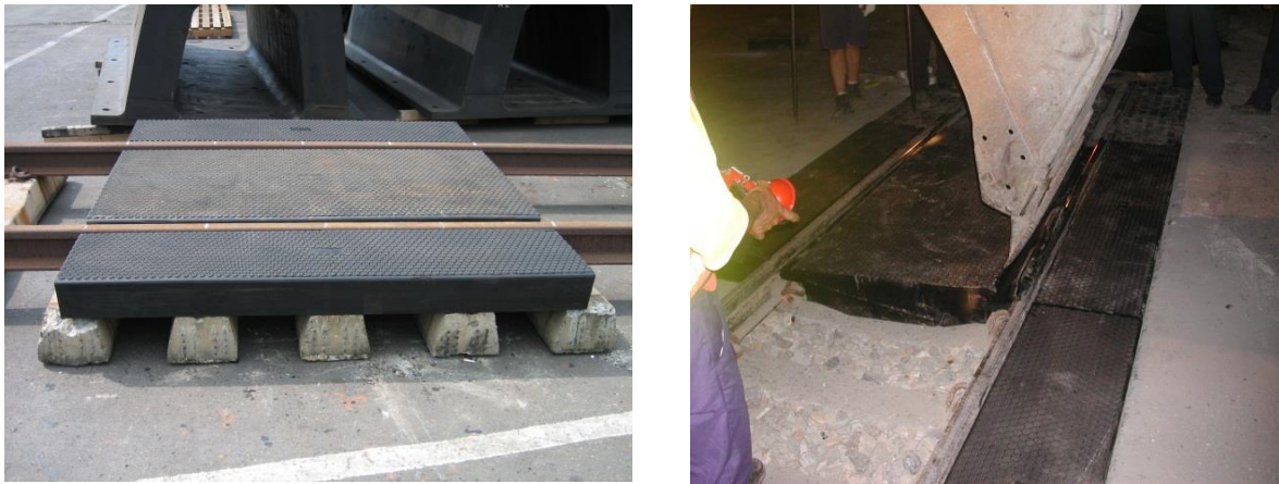
圖 66 臺鐵局橡膠型平交道版直接鋪設於 PC 枕上
