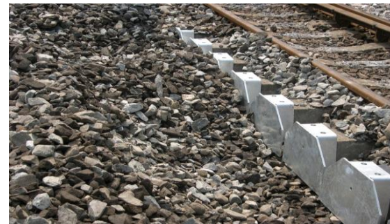
圖 71 臺鐵局挫屈防止鈹安裝
