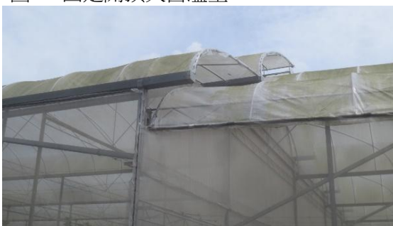
圖 44.固定開頂天窗溫室
