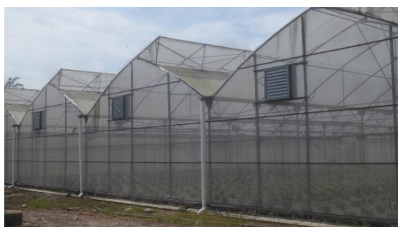
圖 41.固定開頂天窗溫室
