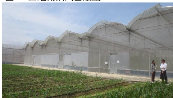
圖 43.固定開頂天窗溫室
