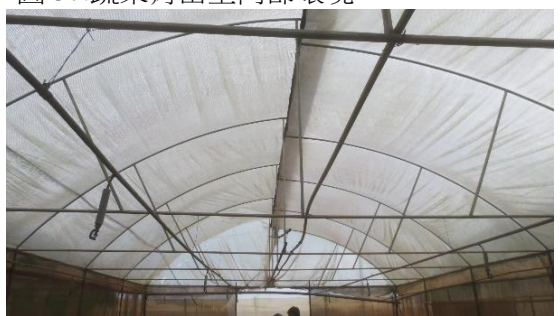
圖 39.圓拱型簡易鋁管溫室開頂結構
