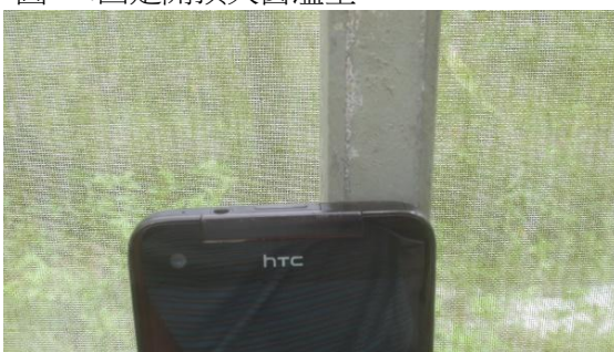
圖 46.2.5cm 的方管方管副柱
