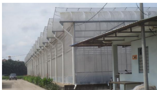
圖 42.固定開頂天窗溫室
