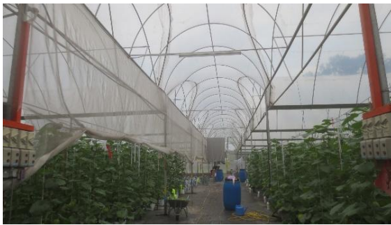
圖 29.圓拱型鍍管溫室內部環境
