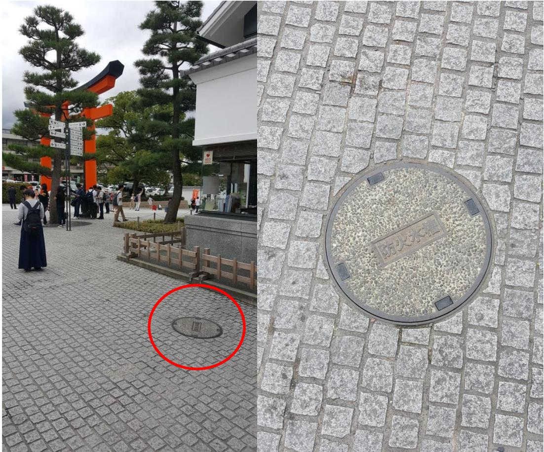
圖 3：伏見稻禾大寺(文化財)防火水槽設置情形
