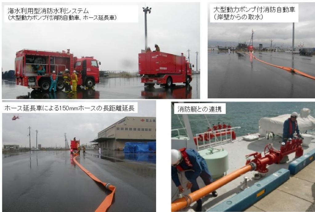
図 15：利用消防車、船進行海水取水運用(神戸市消防局提供)
