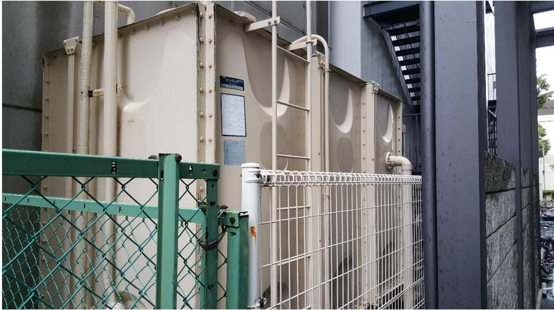
圖 44：住宅區巷道旁所設耐震型防火水槽-1
