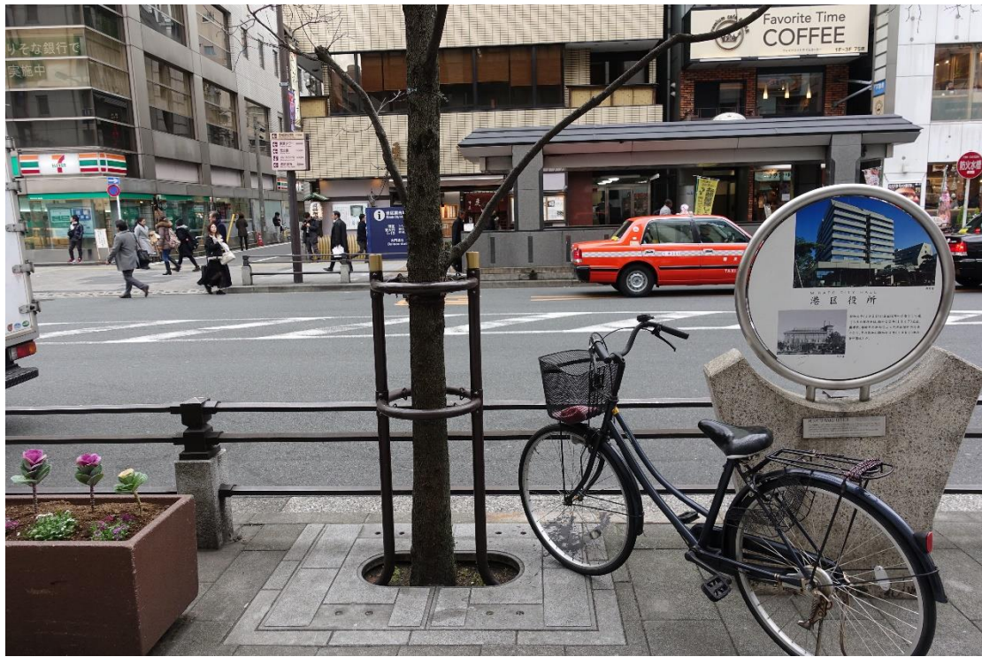
圖15 該區域的行道樹針對樹木的根基部，也進行了完善的保護作業，圖中可以見到根部保護蓋的設置，以及樹幹周圍的防護欄跟活動支撐帶。
