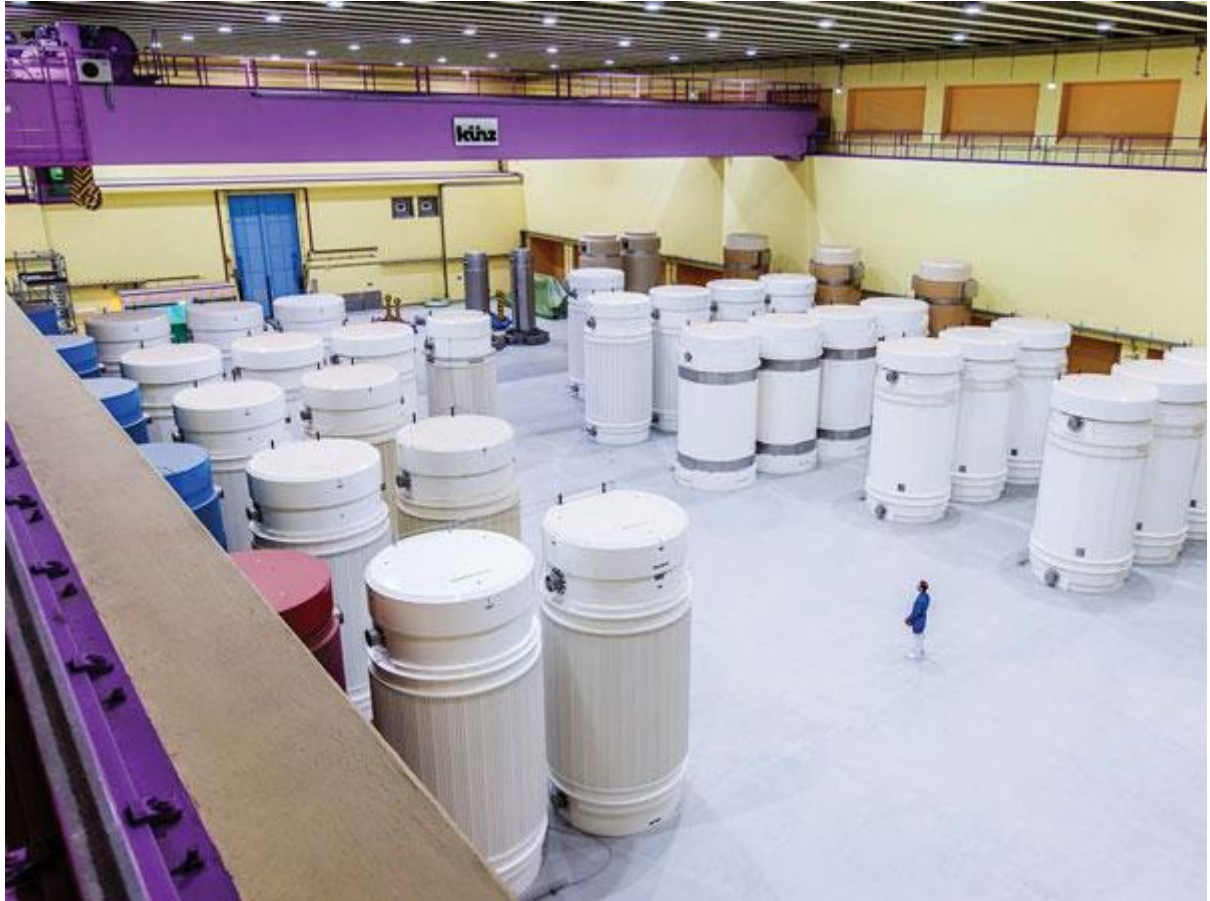
圖 3.1.5 乾貯桶在室內放置的情形及真實比例（以真人比例展示）
