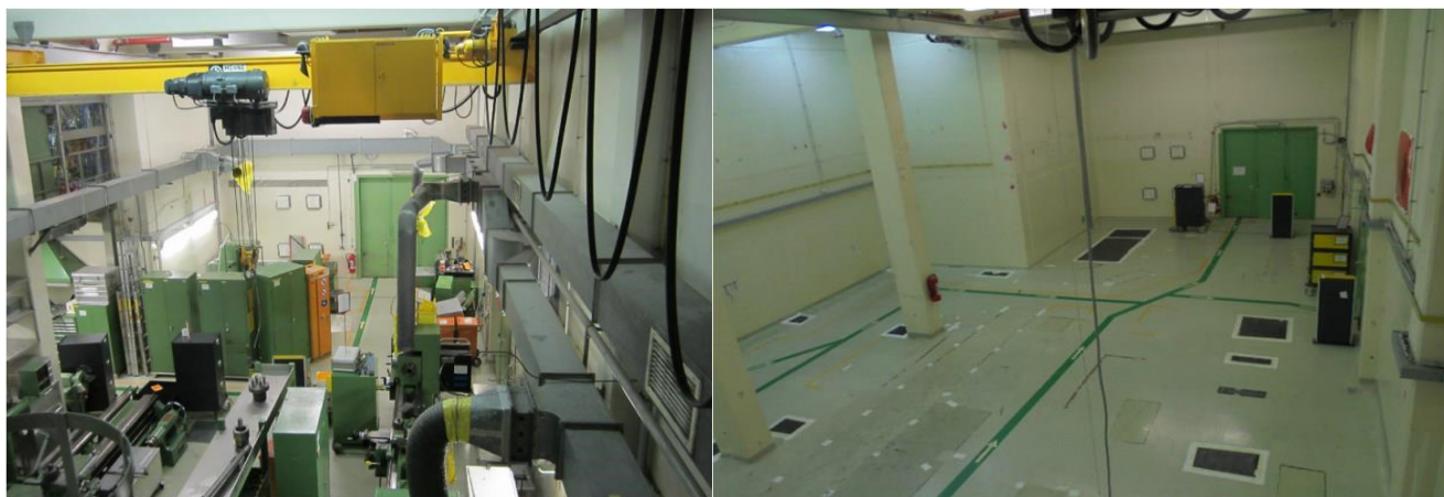
圖 3.1.3 廠房設備拆除前與拆除後的比較圖
