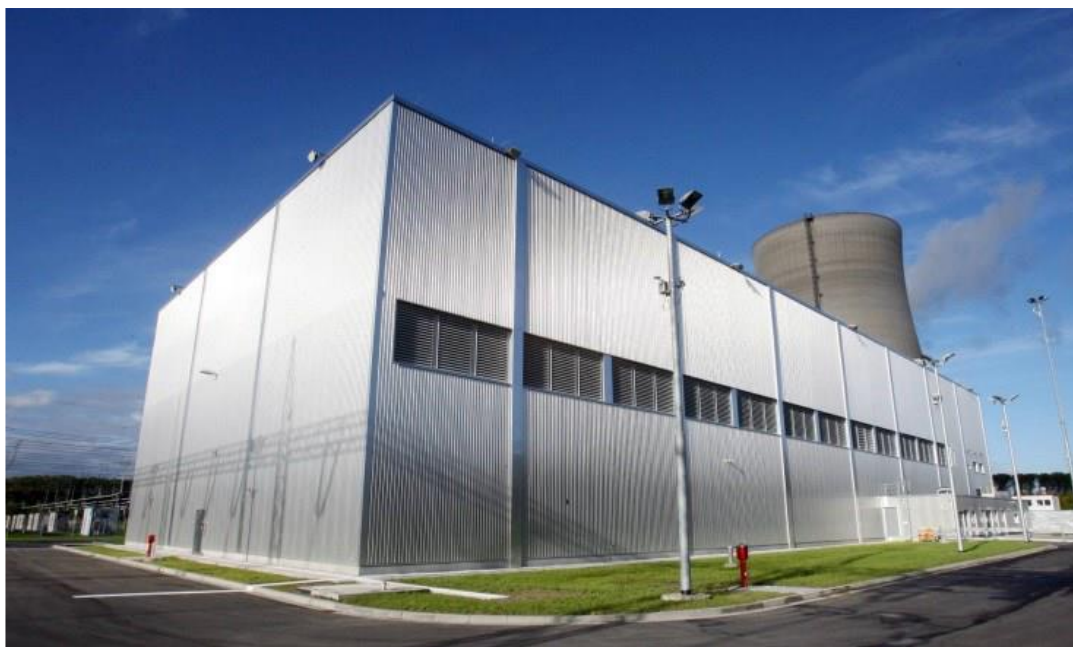
圖 3.1.4 乾貯設施外觀
