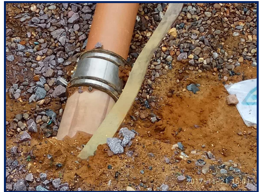
圖 5.1 英國變電站之接地網銅排
