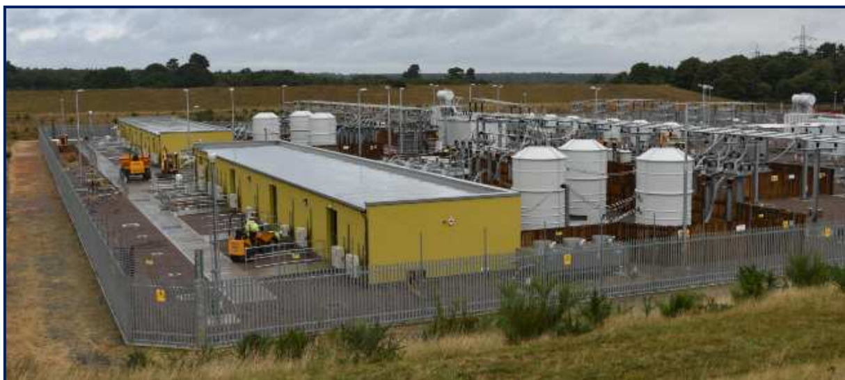
圖 3.20 20 kV 靜態虛功補償設備
