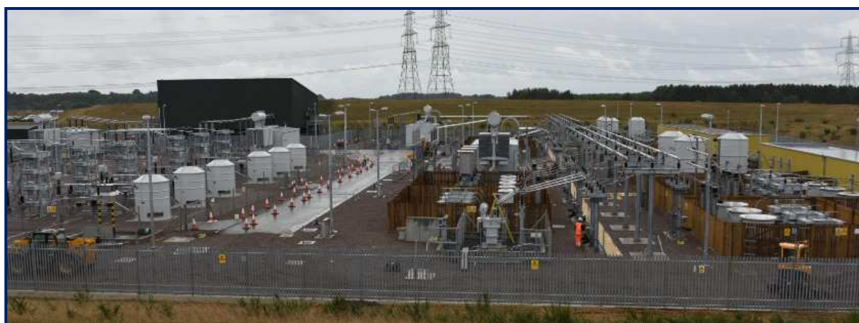
圖 3.21 132kV 40MVAR 諧波濾波器
