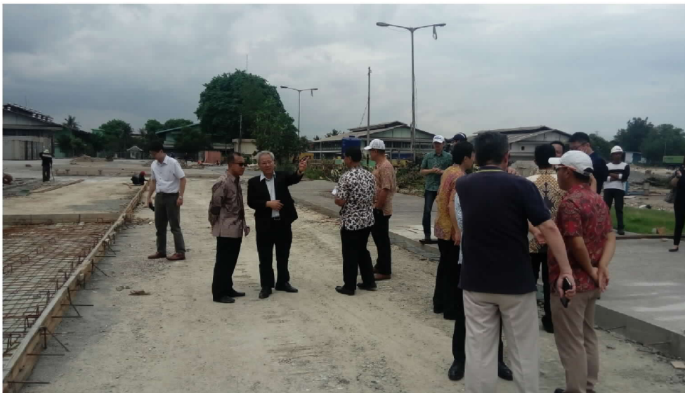
圖 Seacon 興建中內陸貨櫃堆場
