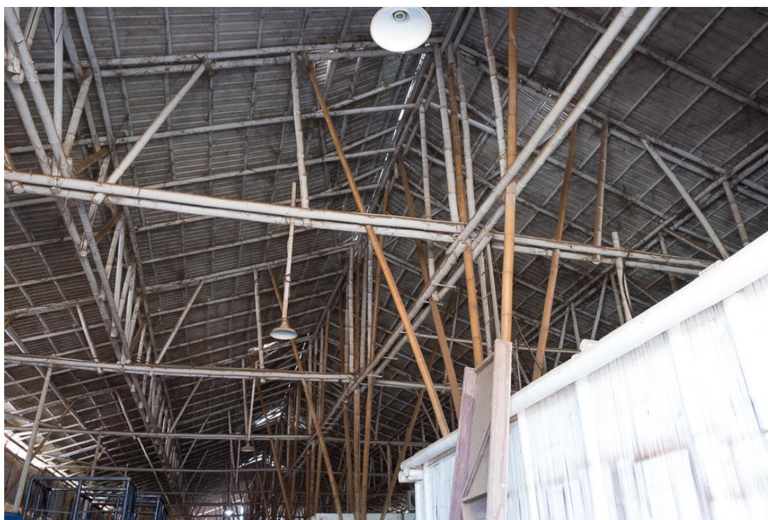
照片3 Indobamboo工場內部竹建築之竹結構。
