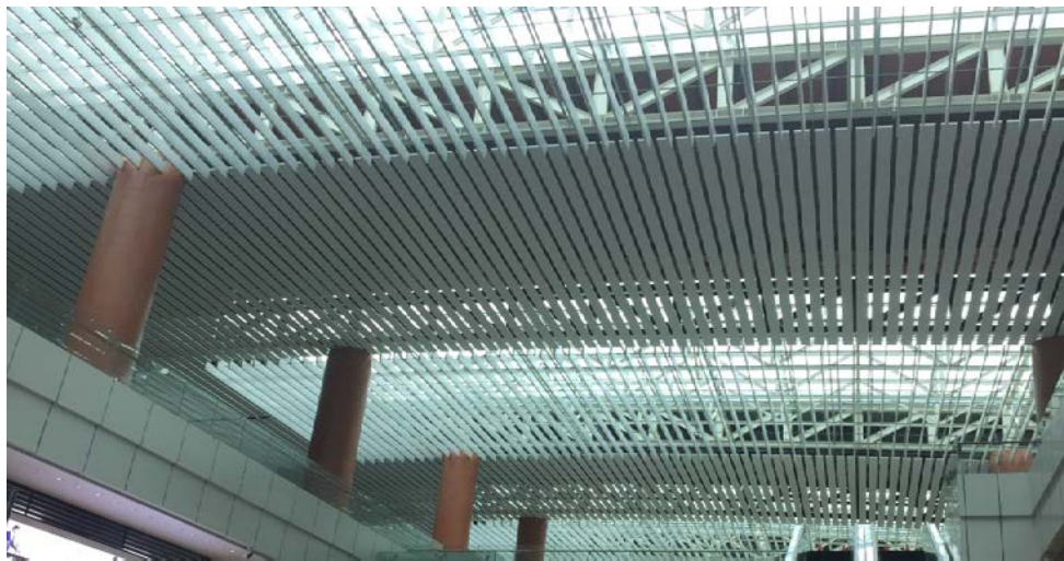
圖 1：T1 航廈屋頂鋼結構工程
