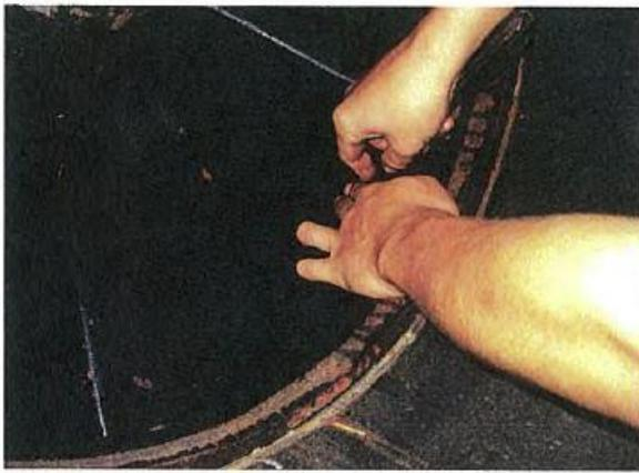
量測葉片與泵殼間之間隙，
