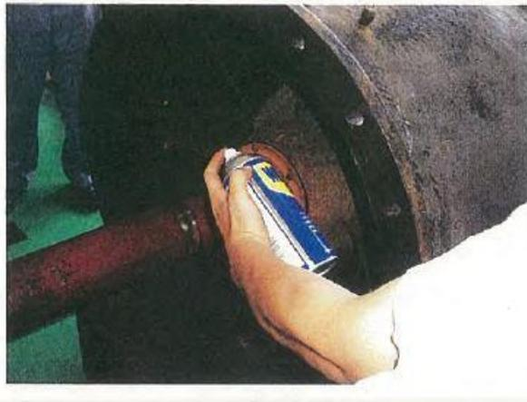
如果泵軸的軸承區非不銹鋼材質，噴防鏽劑以防止長期不使用而生鏽
