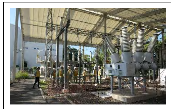
圖 3-74 變電室內訓練場地
