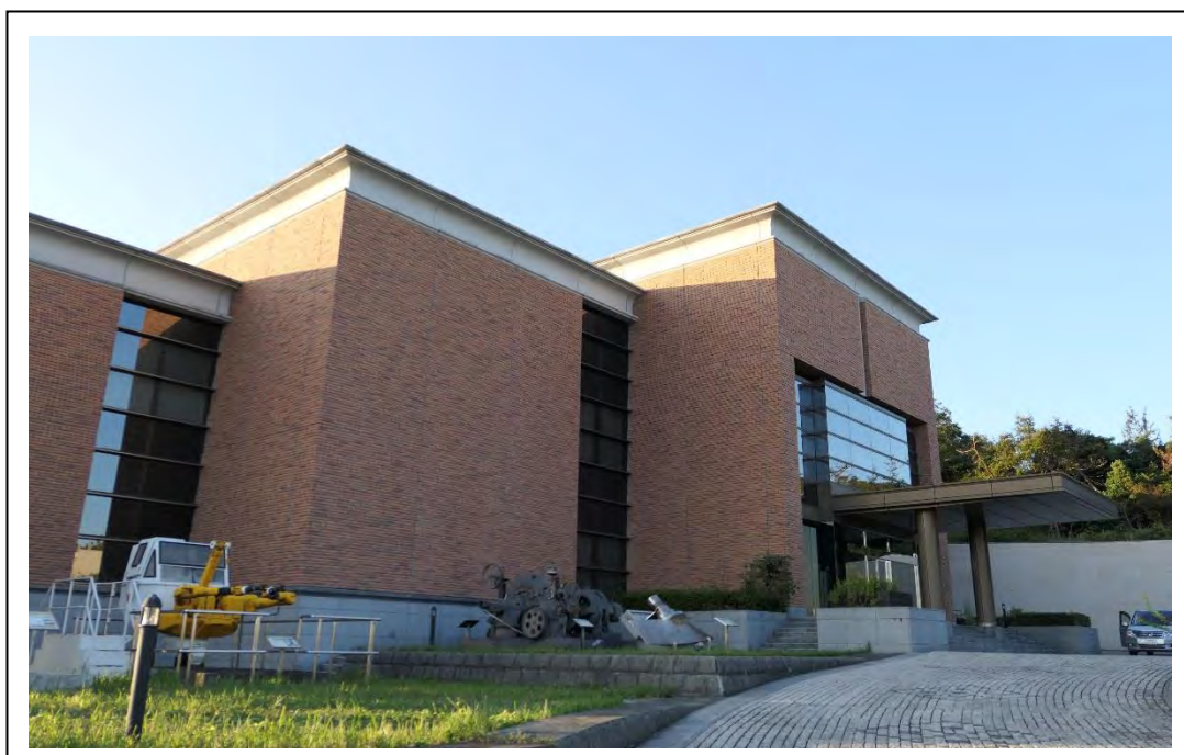
圖3-81 電力史料館全貌
