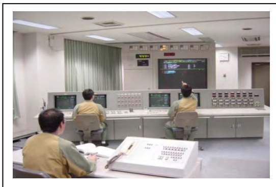
圖 3-77 火力模擬操作設備之 1
