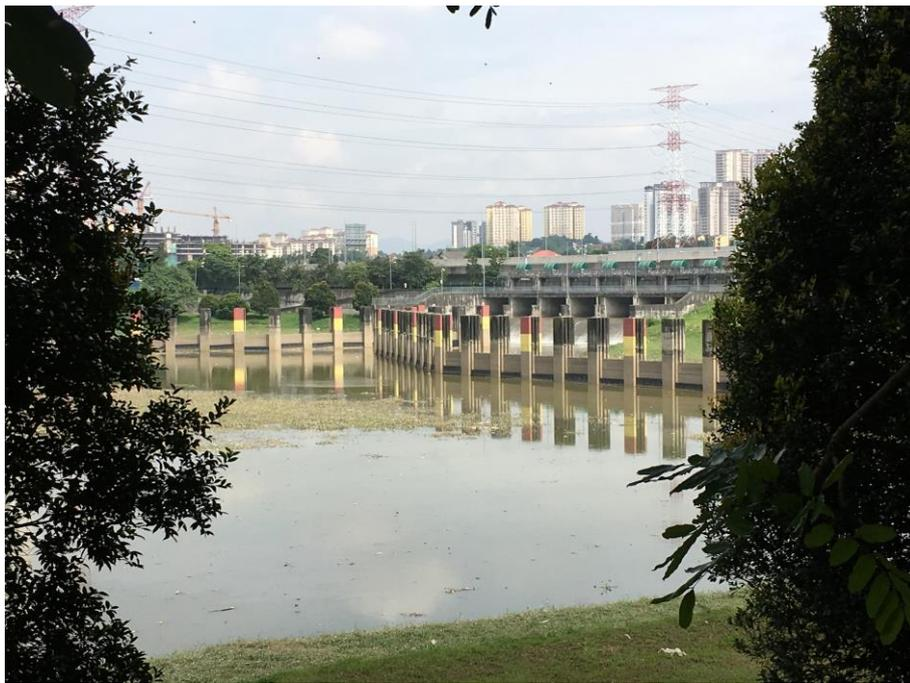
圖 貳-35 參觀精明隧道(SMART)之前池(Holding Pond)及其攔砂設施
