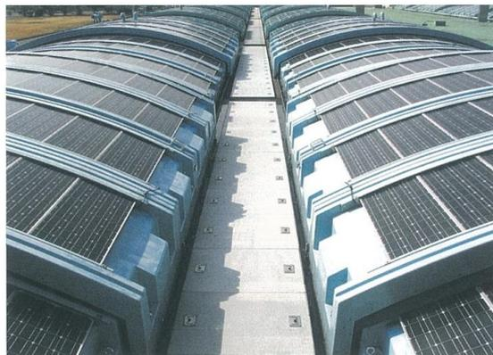
圖 貳-23 淨水廠過濾池上方裝設之移動式太陽能設施
