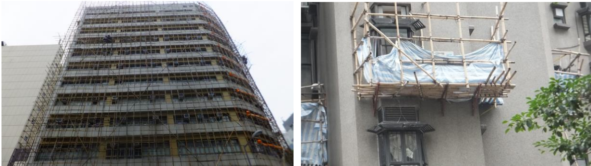
圖 60 香港地區大樓外牆施工採用竹子搭鷹架
