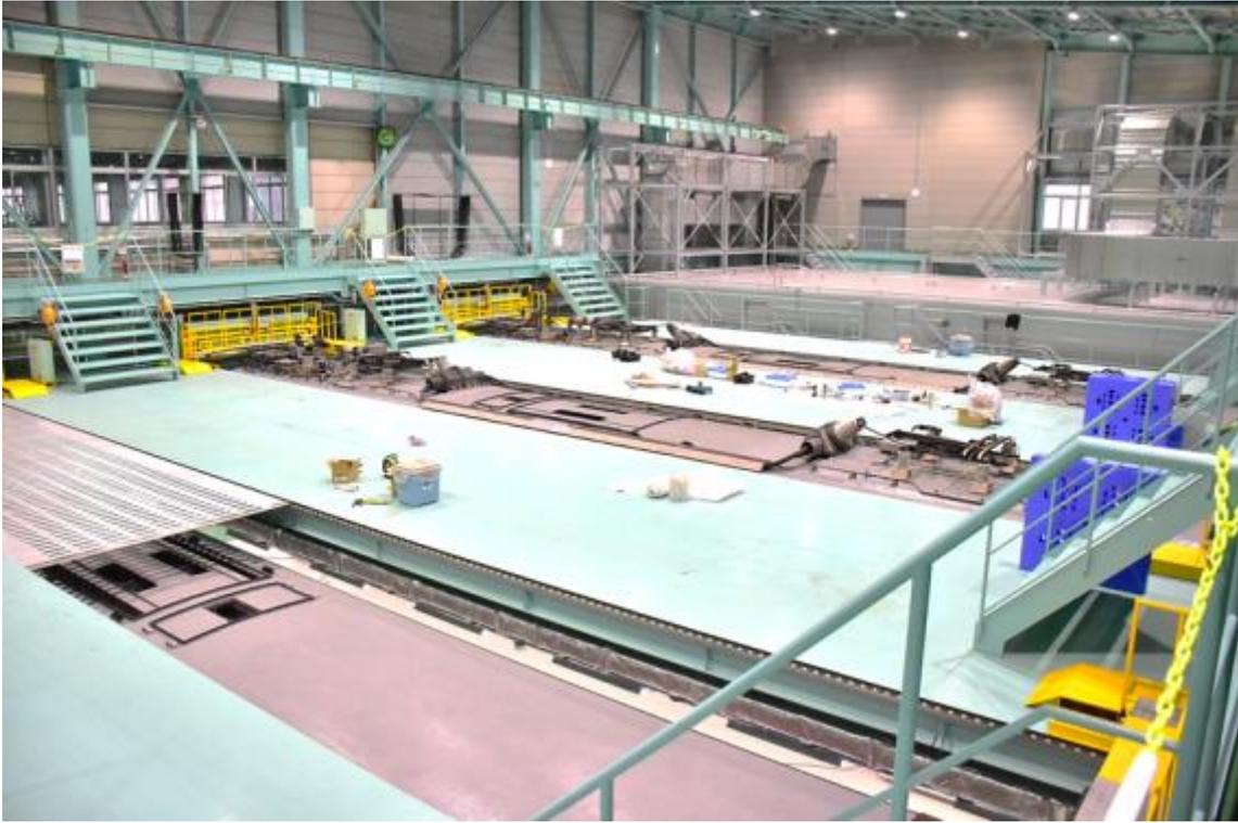
圖 22 車輛更新場電動水平捲動式蓋板
