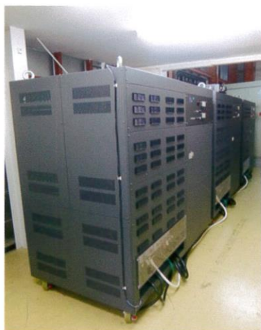
72kVA 対応 3 相電源（高砂製作所）
