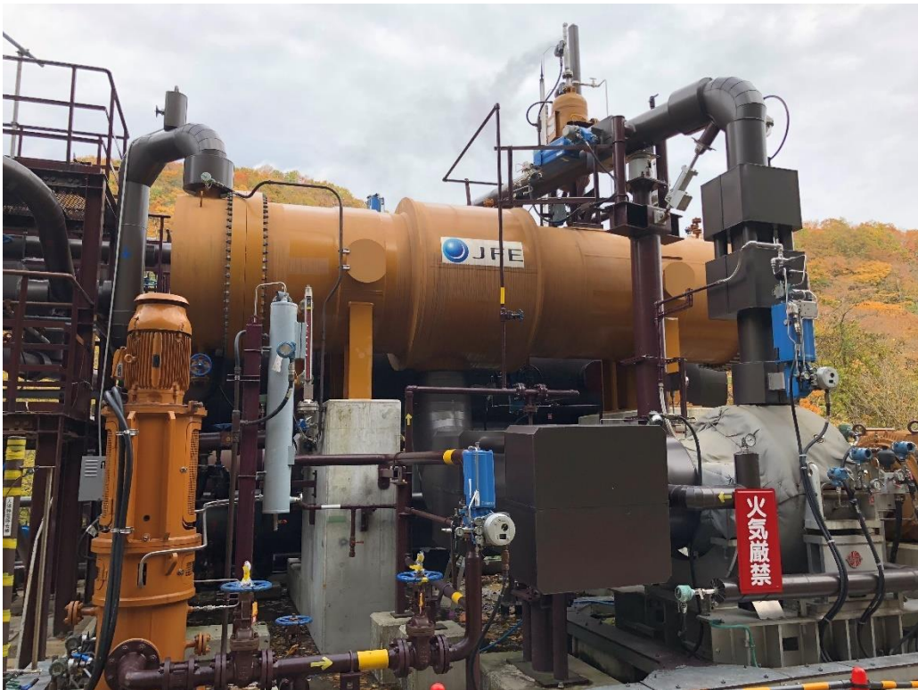
圖 18 地熱發電機裝置
