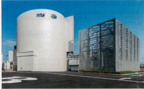
多目的大型実験棟・排煙処理設備
