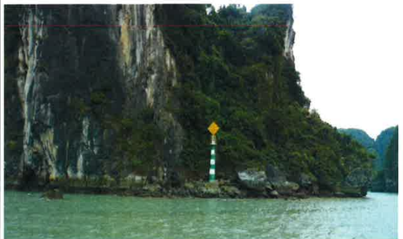
下龍灣島嶼海岸線侵蝕情形(二)
