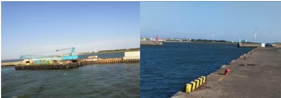
防波堤修復施工情形
