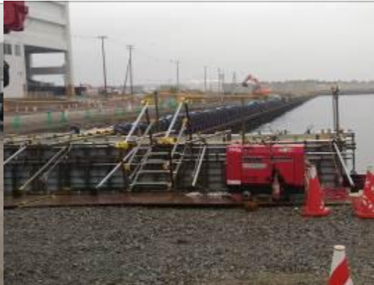
石卷漁港碼頭整建工程
