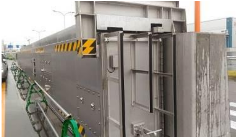
防潮堤自動感應閘門
