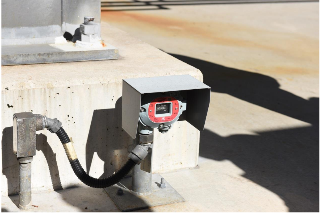
圖 31 設置於工作流體管線周圍的氣體偵測器
