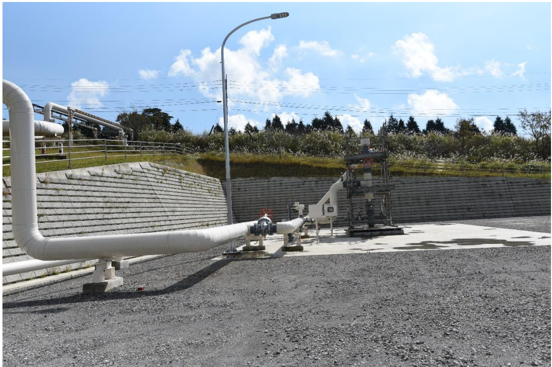
圖 58 大霧地熱發電廠最近剛完工的新井，井深約 3,000 公尺
