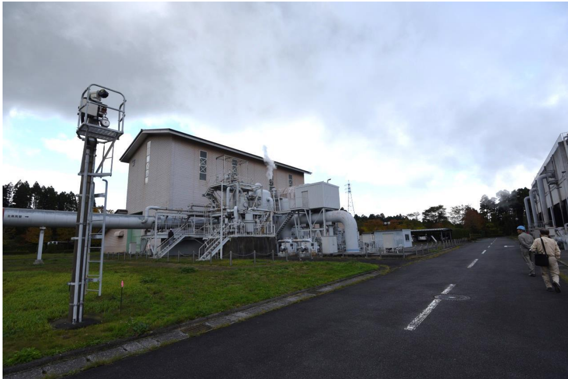
圖 11 滝上地熱發電廠的汽機廠房，右方為冷卻塔
