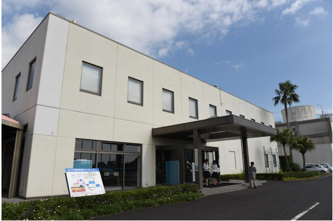
圖 41 山川地熱發電廠展示館
