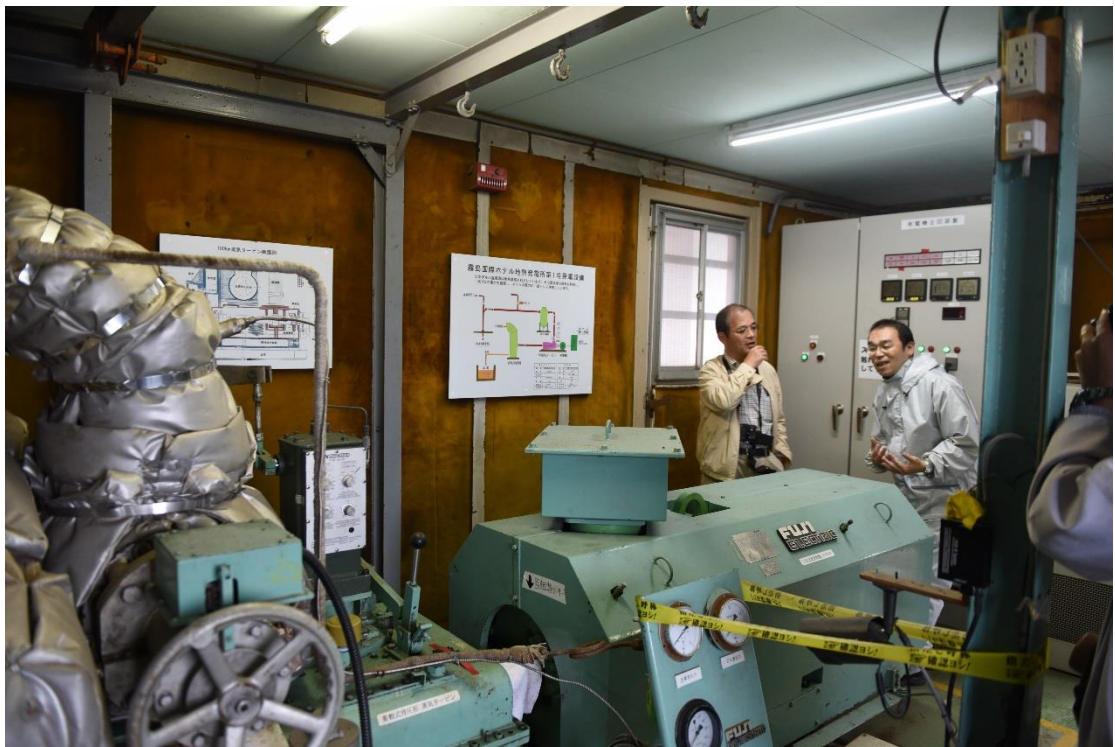
圖 51 霧島國際大飯店地熱發電廠所使用的小型地熱發電機組
