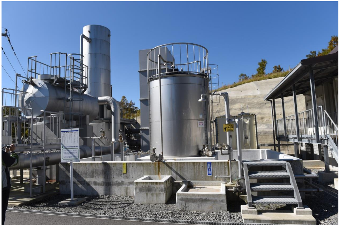
圖 30 調整回注尾水酸鹼度的硫酸儲槽
