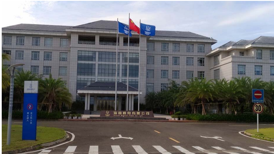
圖一、海南昌江核電廠行政大樓
