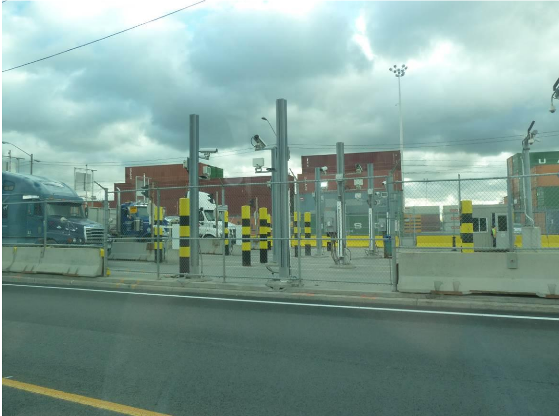
圖3-13 港口入口管制站監視及感應設備
