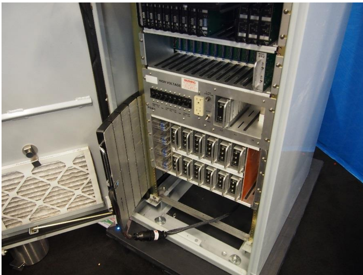
圖3-38 不斷式電源電池可安裝於箱體側邊
