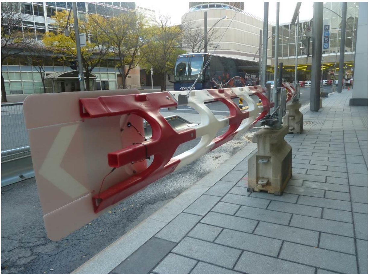
圖3-33 遙控式車道封閉門柵系統設置結構
