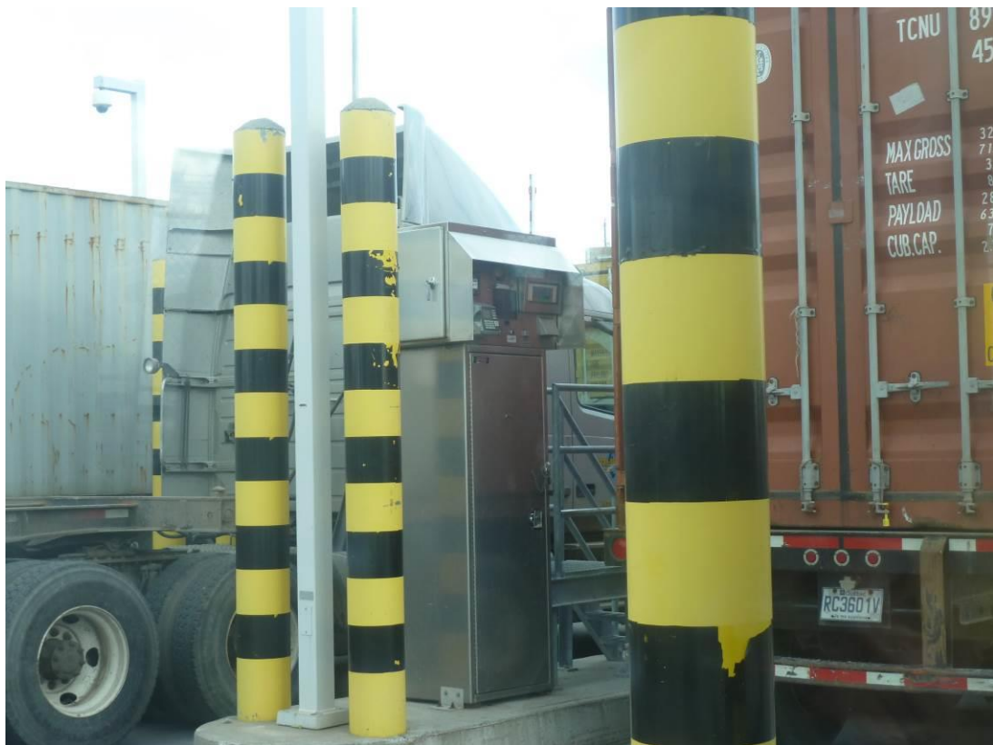
圖3-14 港口入口管制站資料查核設備
