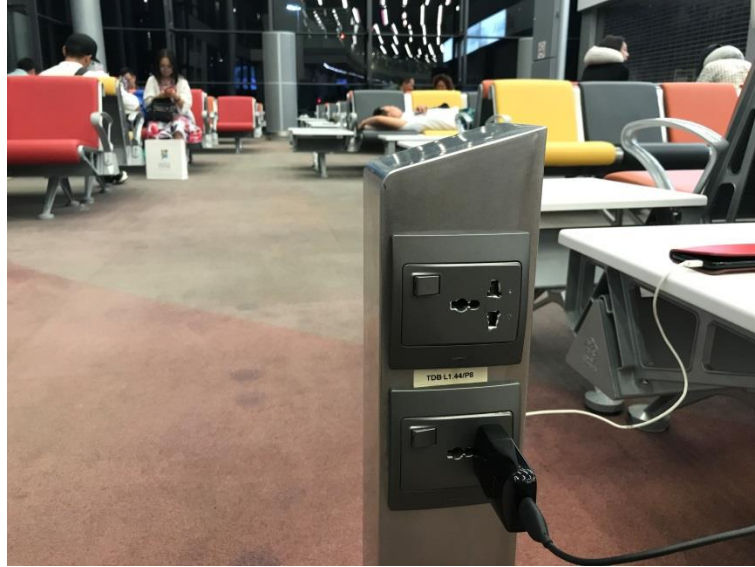
模里西斯機場候機室座位區的充電插座提供國際通用的電源插座
