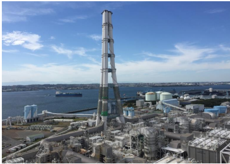
圖 14、碧南電廠第 1 至 3 號機設置全貌
