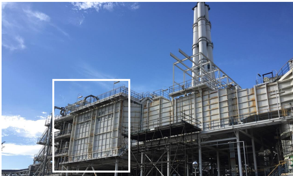
圖 19、碧南電廠第 3 號機 WEP(2 室)設置示意
