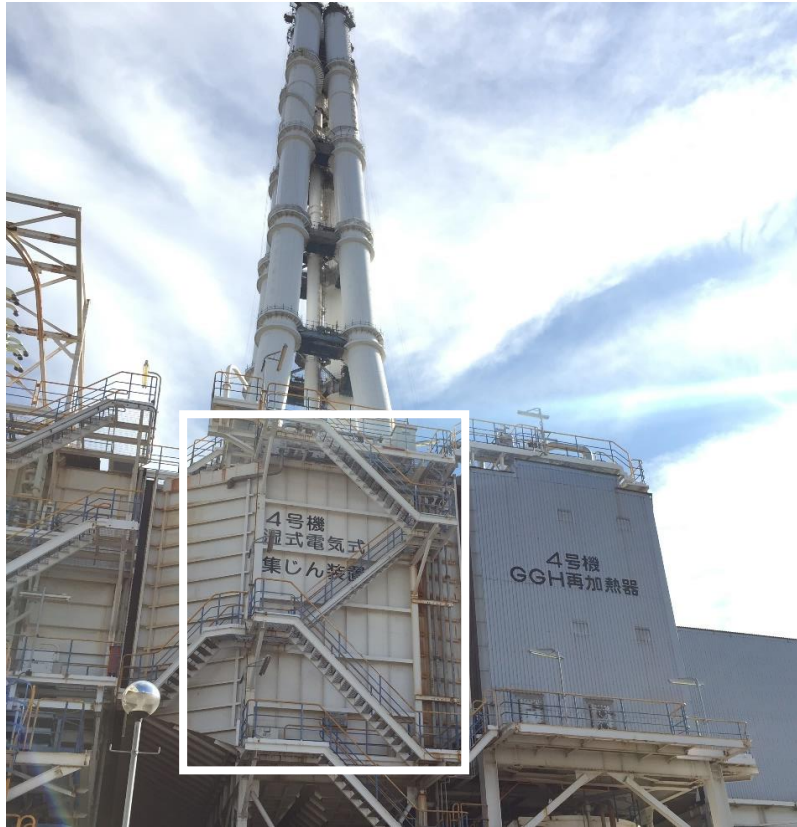
圖 20、碧南電廠第 4 號機 WEP(1 室)設置示意
