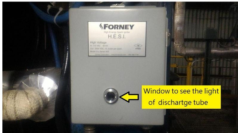
FIGURE 18. WINDOW OF IGNITER POWER UNIT
