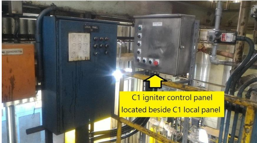
FIGURE 6. C1 IGNITER CONTROL PANEL
