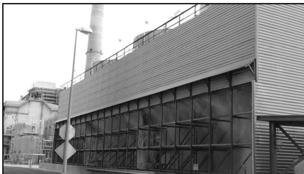
圖 24：煙道氣流中噴灑水煙氣直接接觸式冷卻器設備
