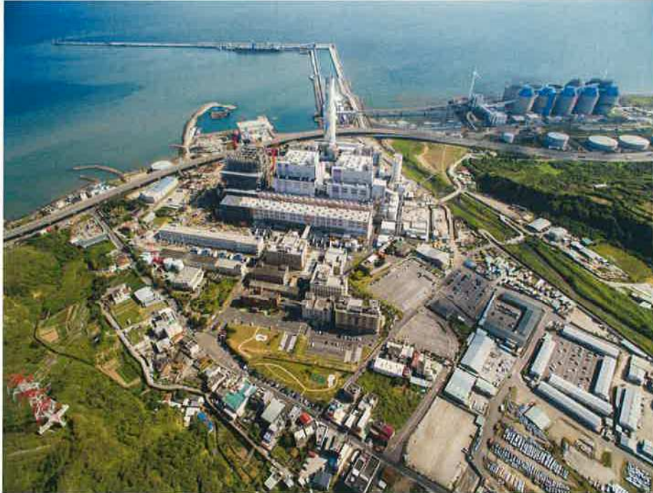
林口電場全廠區照
