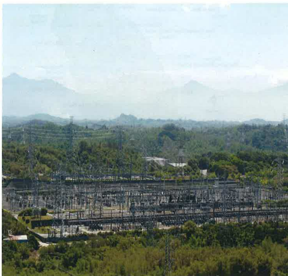
圖 2 改建前之龍崎超高壓變電所
