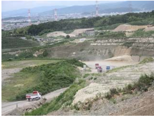
場區內作業情形 1
