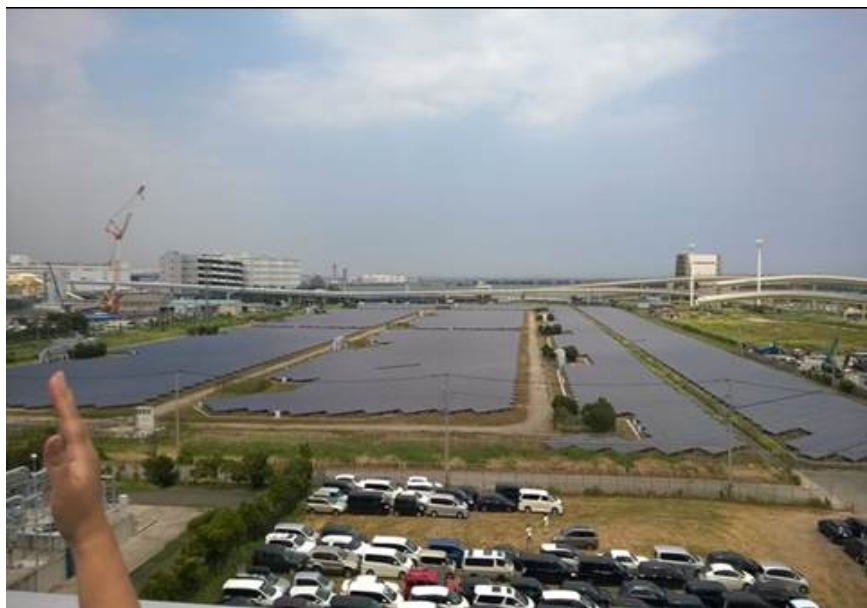
浮島太陽能發電場(浮島廢棄物處理中心三樓)
