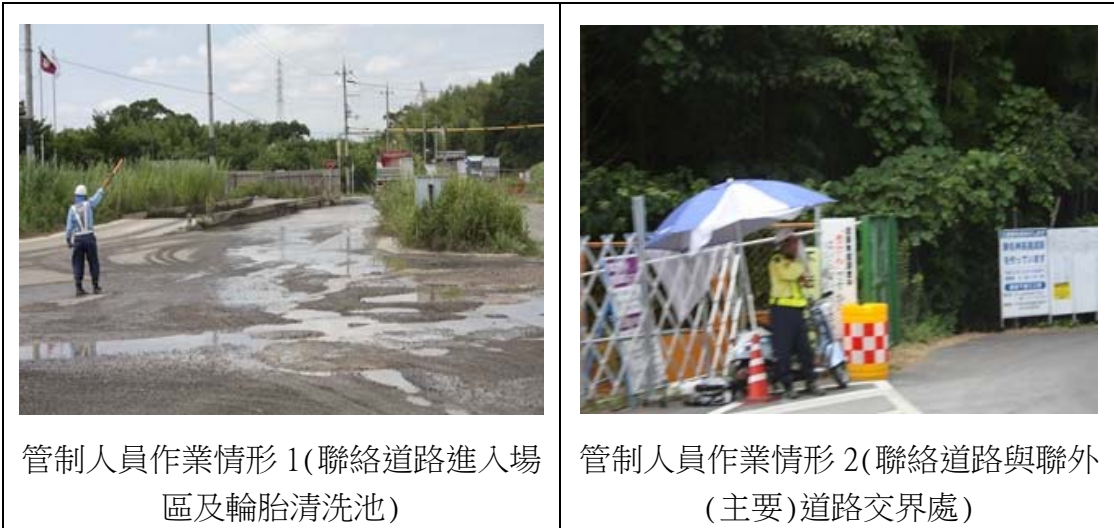
圖 3-1-20：城陽市山砂利採取作業及營建剩餘土回填情形
