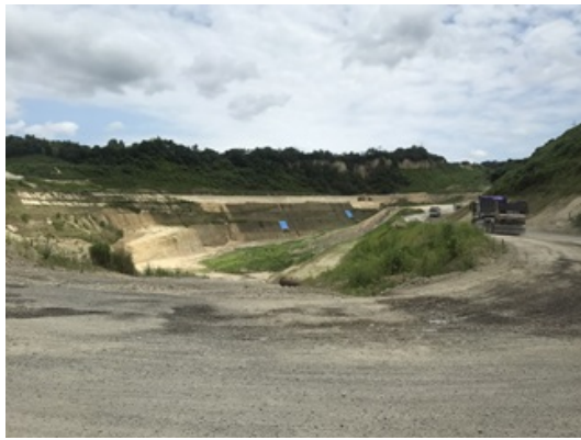
場區內作業情形 2(採掘跡地)
