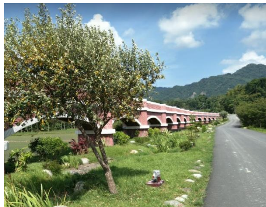
圖 2 台灣台東縣二層坪水橋
