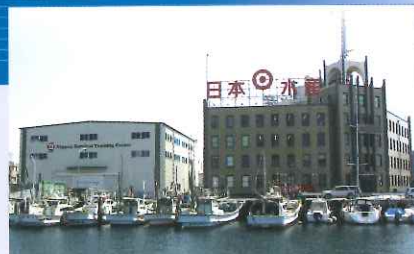
訓練棟・ニッスイ戸畑ビル Training Facility・NISSUI Tobata BLDG.
