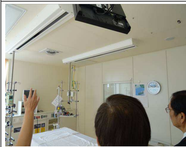
參觀HCU病室的懸吊設備。
