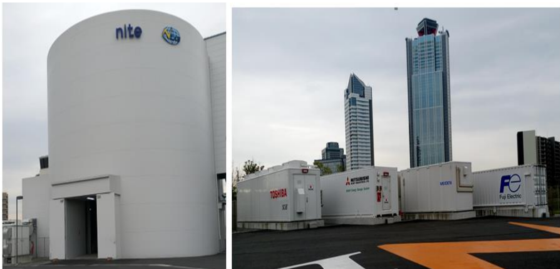
圖 12 NLAB Large Chamber 測試中心外觀及待測大型儲能貨櫃
