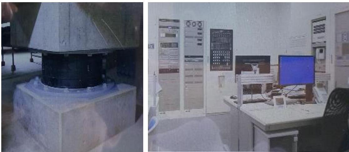
圖 23 位於 B1 樓減震裝置與 1 樓輔助防災中心
