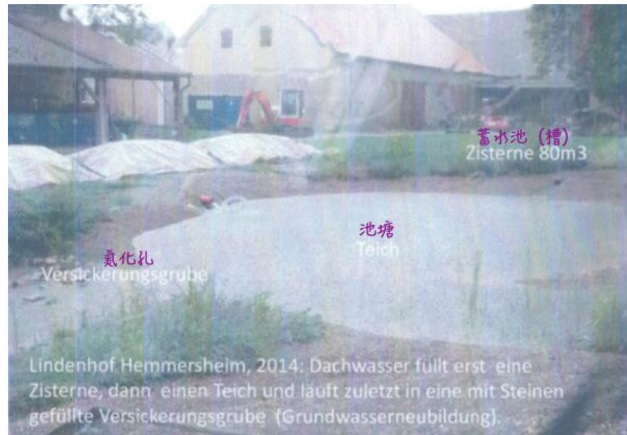
圖 3-12 農場打造雨水蓄水池
