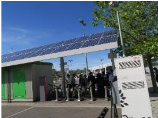
圖 40 南十字車站附件的太陽能設備、電動自行車與電動巴士站
