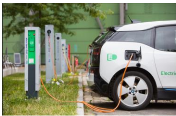
圖 18 不同類型的充電柱(用電線)
