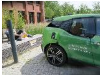
圖 19 不同地點不同類型的充 電柱(用電線)
