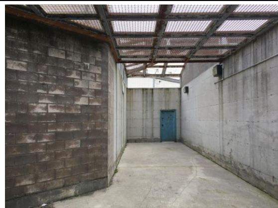
(圖 65：Collins Bay 監獄中高度舍房運動區)
