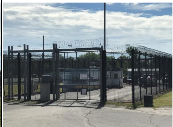
(圖 28：Millhaven 監獄車檢站)
