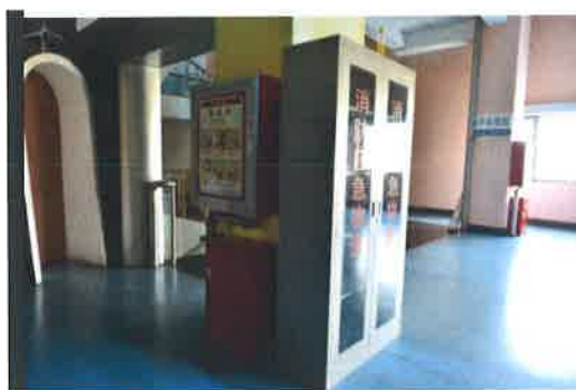
照 63 天津科學技術館消防設備站
